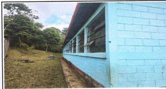
Foto 3: SE CAMBIARAN ALGUNAS VENTANAS QUE SE ENCUENTRAN EN MAL ESTADO.
