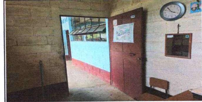
Foto 6: SE REALIZARA CAMBIO DE PUERTA DE LA DIRECCION QUE SE ENCUENTRA EN MAL ESTADO.
