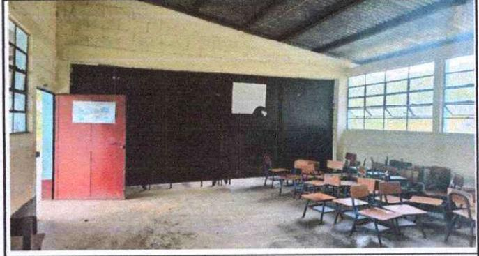
Foto 2: SE CAMBIARA LAMINAS Y COSTANERAS QUE SE ENCUENTRAN EN MAL ESTADO.
