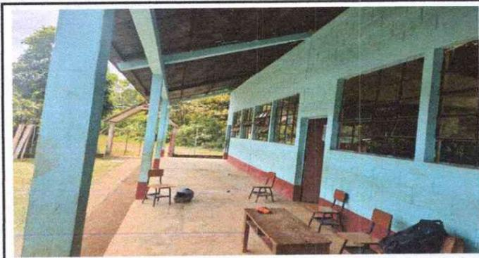
Foto1: SE REALIZARA PINTADO DE PARED INTERIOR Y EXTERIOR ASI MISMO SE CAMBIARA LAS PUERTAS QUE ESTAN EN MAL ESTADO.
